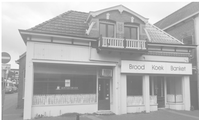
Bestaande situatie van Pand Hoofdstraat Oost nr. 13
