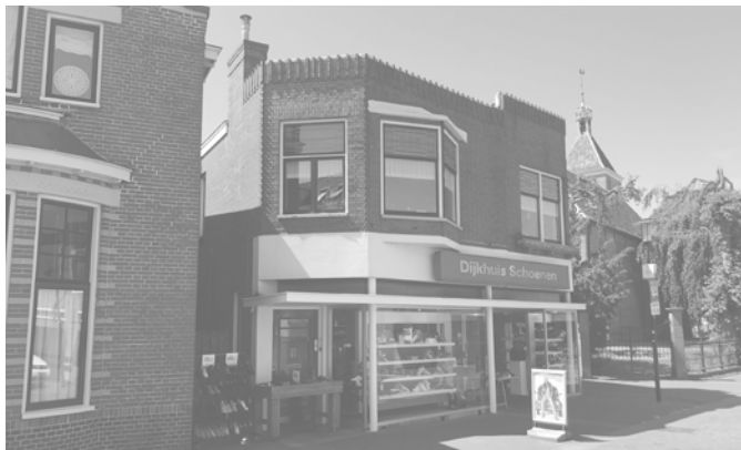
Bestaande situatie van Pand Hoofdstraat Oost nr. 4
