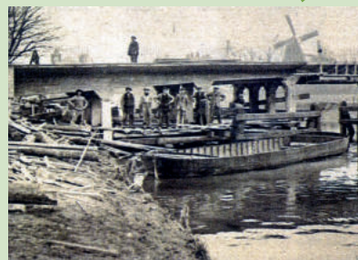
Aanleg van provinciale weg en nieuwe brug over Winsumerdiep, 1927. Dit was een van de eerste geasfalteerde wegen in Groningen. Foto's: Historische Vereniging Winsum-Obergum.
