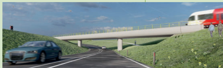
Nieuwe ontsluitingsweg (de Melkweg) ten oosten van Bedum om vrachtverkeer door de dorpskern om te leiden. Hierbij zijn drie onbewaakte spoorovergangen vervangen door een spooronderdoorgang. [Provincie Groningen]
