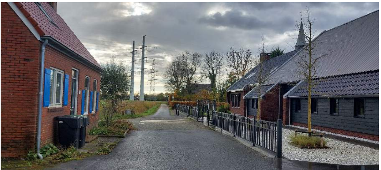
Huidig zicht vanuit Klein Wetsinge naar het zuiden. Het huidige zicht op de TenneT-masten is hier niet te missen.
