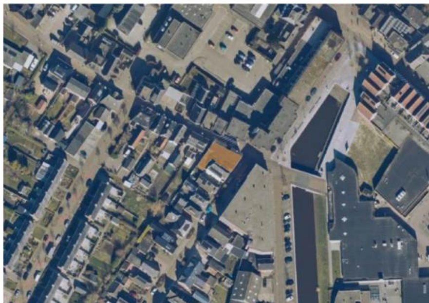
Figuur 18: Locatie Bouw van huurwoningen
