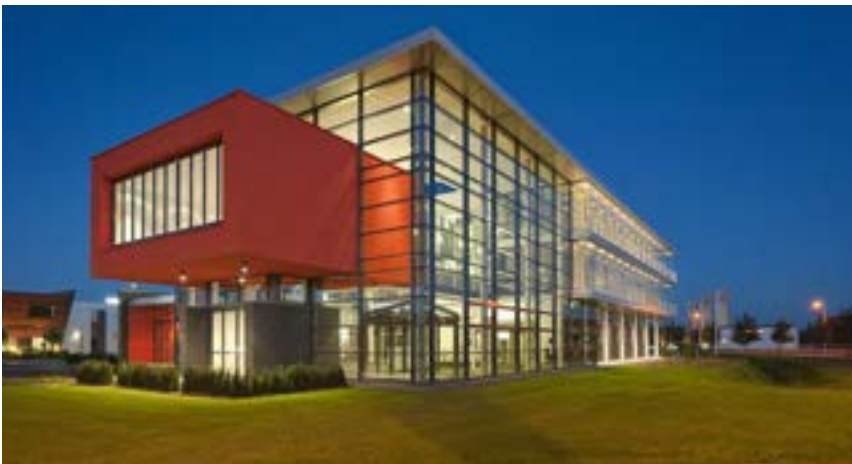
Afbeelding 33: energiezuinig ontwerpen van gebouwen, zoals een vouwbare gevel in dit voorbeeld. Een geïsoleerde gevel, bestaande uit houten vouwwanden met hoogwaardig isolatieglas.
