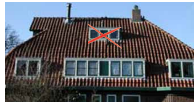
Te veel dakkapellen in één dakvlak; geen dakkapel in bovenste geknikte deel van het dak
