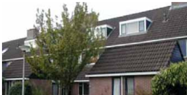
Bijgebouwen op het voorerf zijn in vormgeving en detaillering overeenkomstig het hoofdgebouw
