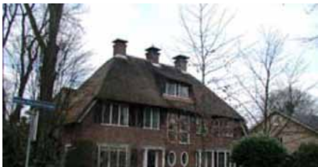
Aangekapte dakkapel toegestaan bij rieten dak
