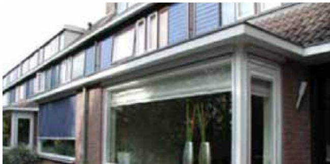
Uitbouw die in hoogte en breedte goed aansluit op de goothoogte van het gebouw
