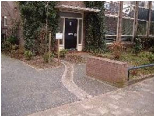
Afvoergoot naar het trottoir
