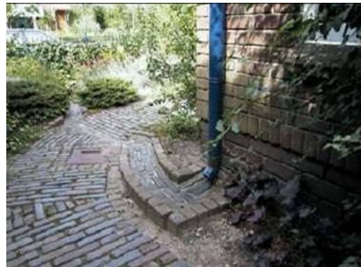
Afvoergoot naar het trottoir
