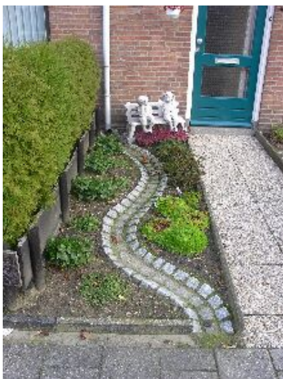
Afvoergoot naar het trottoir
