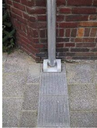
Afvoergoot naar de straat
