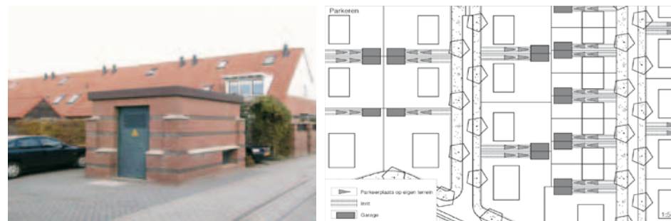
De vormgeving van nutsgebouwtjes vertoont overeenkomsten met de woningen
