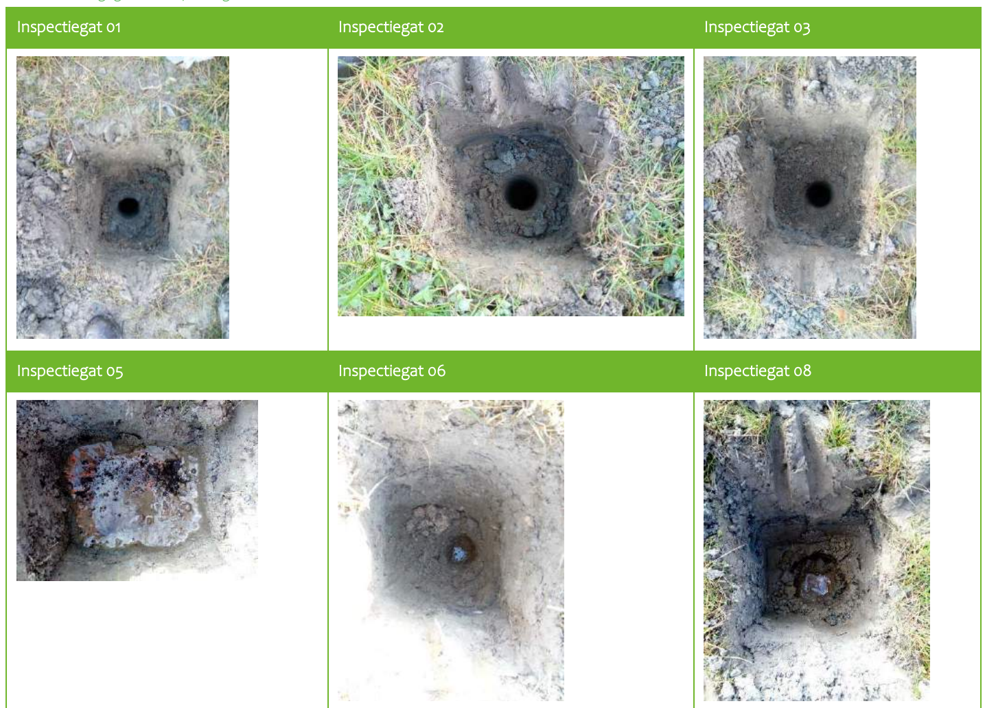
Foto's van de gegraven inspectiegaten
