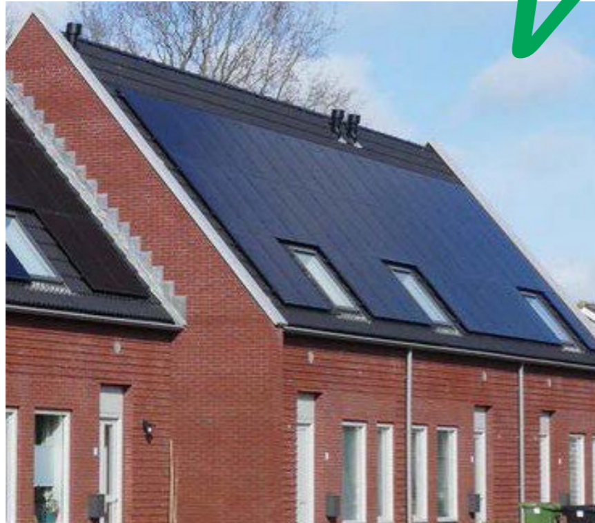
Antraciet zonnepanelen op een antraciet dak in patroon tussen de dakopeningen.
