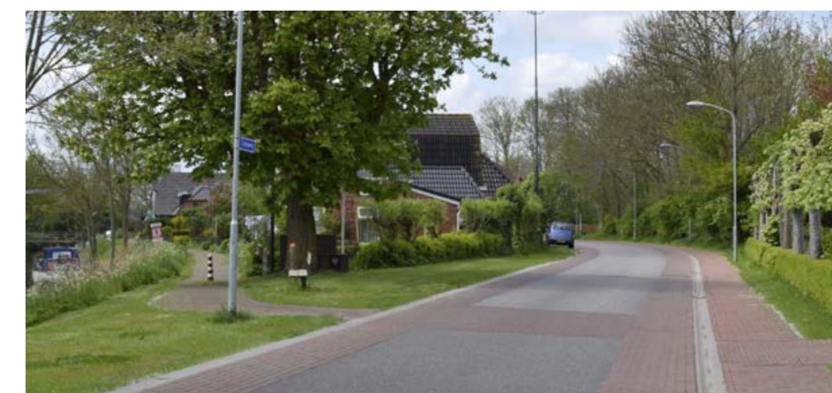
Asfalt met slijtlaag en streklagen van klinkers
