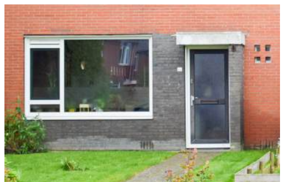
Accentvlak in zwarte baksteen in bestaande bouw
