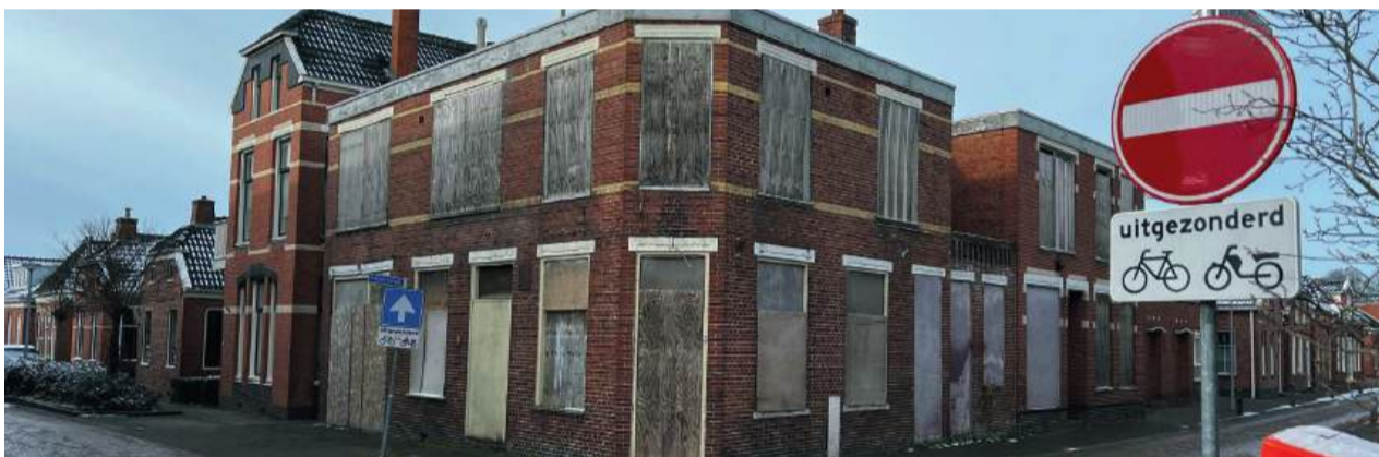
Op dit moment wordt het gebouw gesloopt. De gemeente en Goud Wonen trekken samen op voor de ontwikkeling van nieuwbouw woningen op de plek waar vroeger De Komeet zat.
