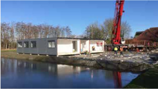
Plaatsen tijdelijke basisschool Kantens
